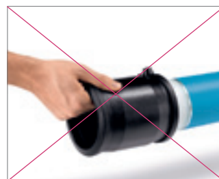
Рис. 72 Не касайтесь внутренней поверхности электросварной муфты
