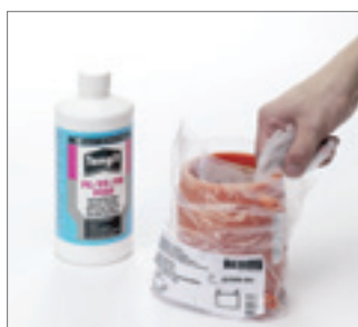
Рис. 114 Электросварную муфту FUSAPEX вынуть из упаковки непосредственно перед проведением работ
