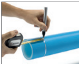
Рис. 65 Для контрастности отметок используйте маркер другого цвета, чем труба
