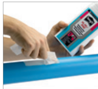
Рис. 55 3. При необходимости обработать зону сварки жидкостью Tangit
