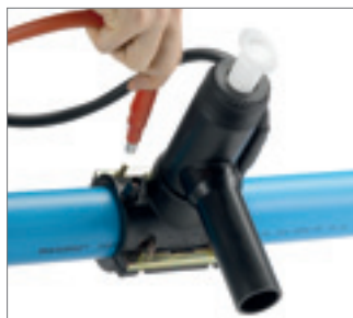
Рис. 57 5. Подключить сварочный аппарат: красный провод к красному контакту. Параметры сварки определяются автоматически
