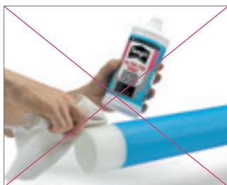
Рис. 74 Нельзя применять для очистки и протирки использованную ветошь. Используйте только негигроскопичные специальные салфетки
