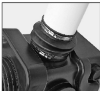
Рис. 9 Монтаж вентиляционного трубопровода
