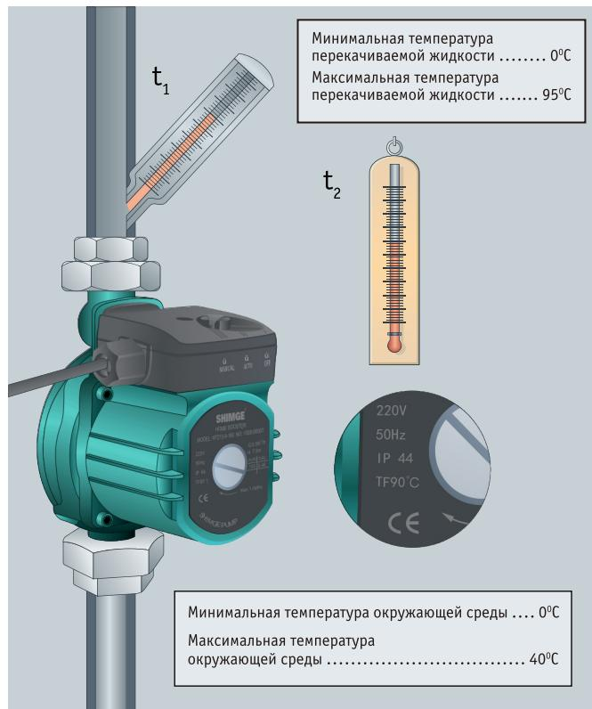
Водный поток должен проходить через насос в направлении указанном на стрелке, расположенной на корпусе устройства. Никогда не устанавливайте насос против тока воды, поскольку это может вывести насос из строя.
