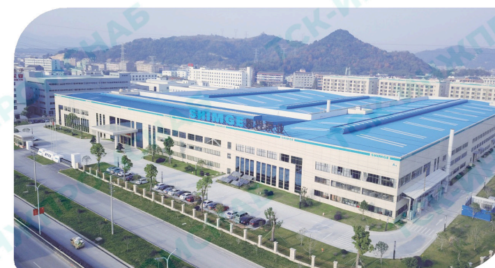
Производственная база Shimge в Санцику, Вэньлин, провинция Чжэцзян
