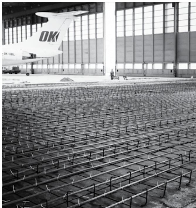
Напольное отопление для промышленных зданий
