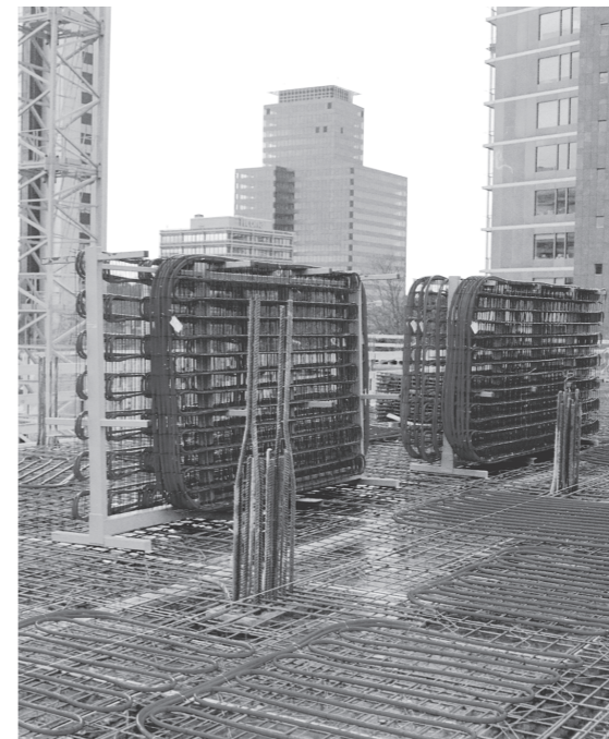
Подогрев и охлаждение ядра бетонных перекрытий
