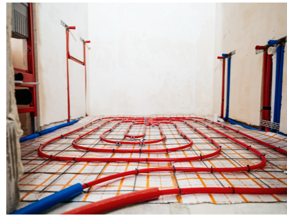
Крепление труб на арматурной сетке
