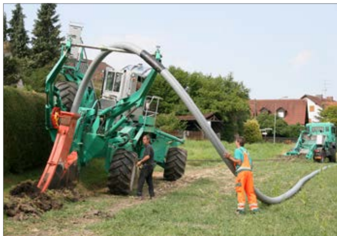
Рис. 7-8 Прокладка труб плужным методом
