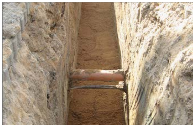
Рис. 7-2 Дно траншеи с опорой для трубы
