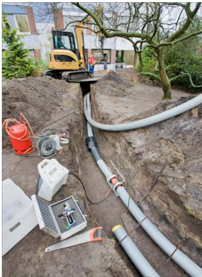
Рис. 4-11 FUSAPEX – соединение электросварными муфтами на практике
