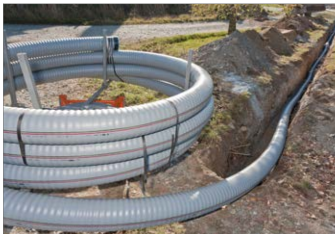
Рис. 7-29 Стационарное горизонтальное размоточное устройство в конце траншеи.
