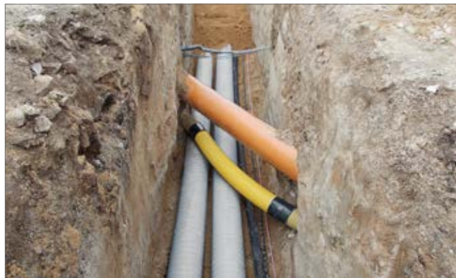
Рис. 7-19 Прокладка под пересекающимися трубопроводами
