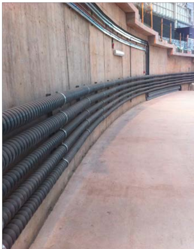
Рис. 7-25 Пример монтажа на стене/свободной прокладки
