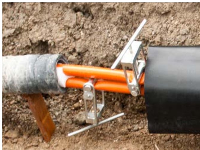
Рис. 7-27 Пережатие внутренней трубы DUO
