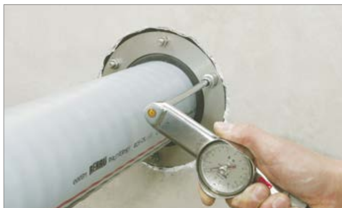
Рис. 5-14 Монтаж с применением динамометрического ключа
