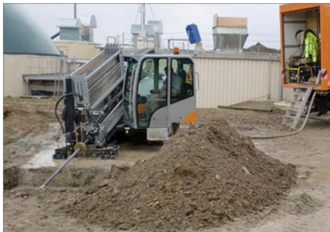
Рис. 7-10 Прокладка труб способом бурения
