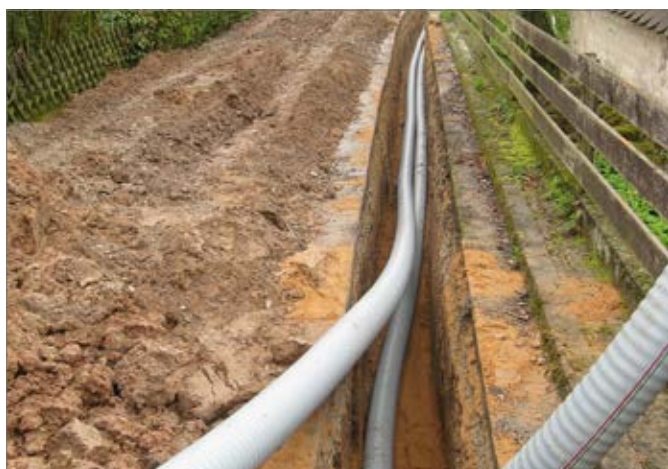
Рис. 7-4 Прокладка открытым методом в траншее
