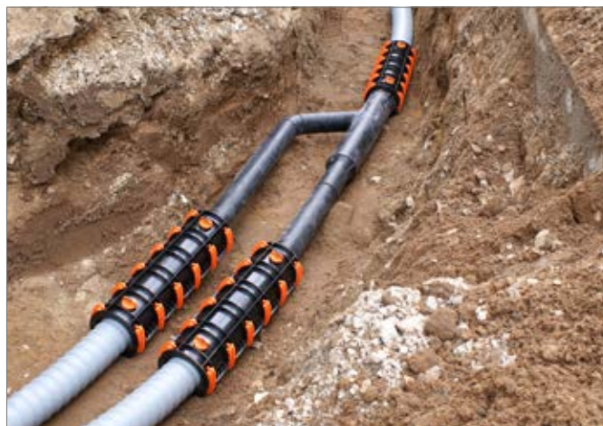
Рис. 4-30 Монтаж разветвителя на практике
