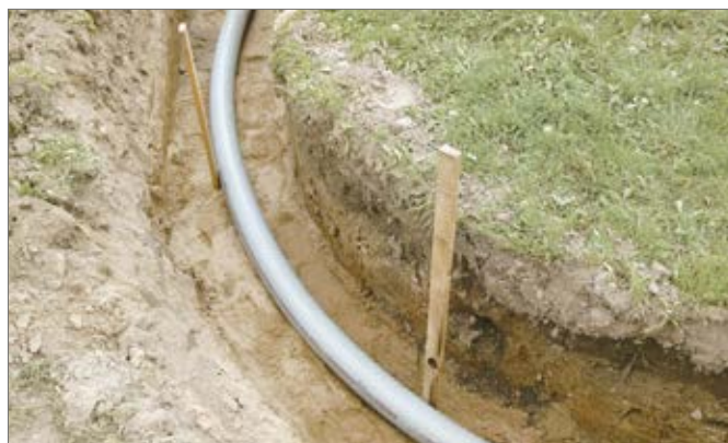
Рис. 7-20 Изменение направления без частей формы.
