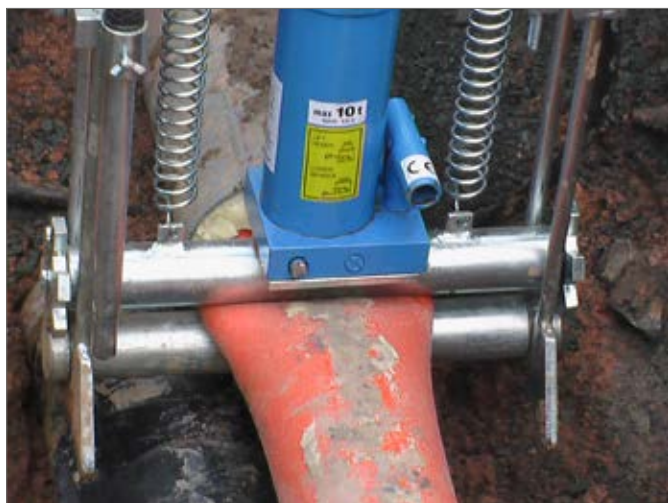
Рис. 7-26 Пережатие внутренней трубы UNO
