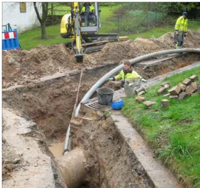
Рис. 7-21 Простая прокладка гибким трубопроводом
