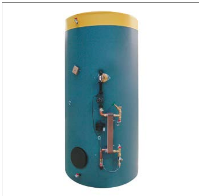
Рис. 6-9 Децентрализованный тепловой аккумулятор (накопитель)
