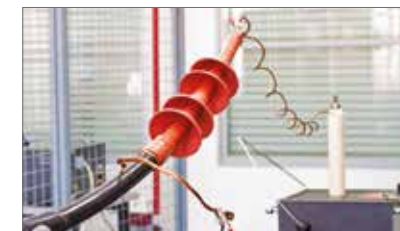
Высоковольтные испытания кабельных муфт
