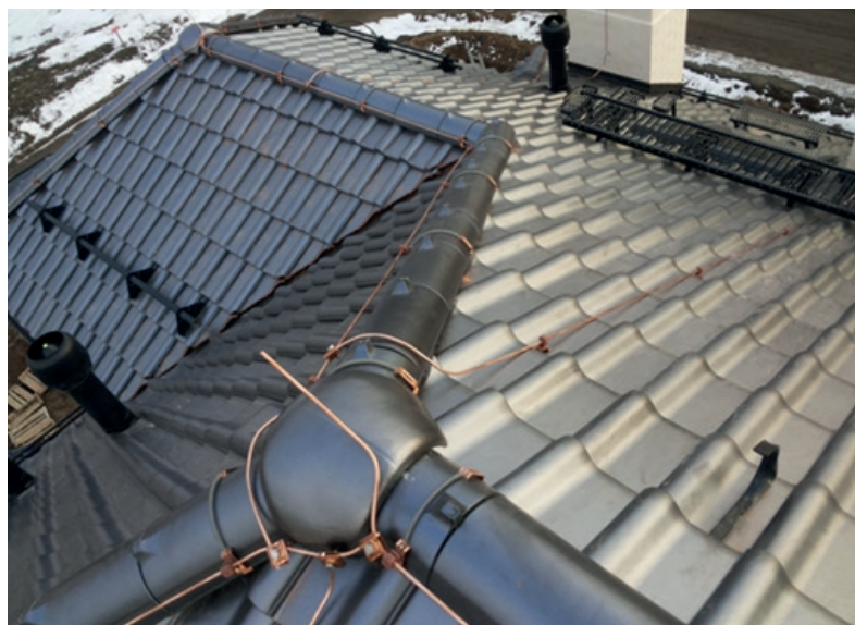
Молниеприемная сетка на скатной кровле
