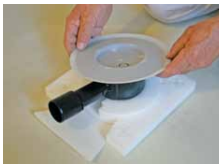
7. Установить корпус трапа с монтажной заглушкой
