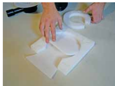
6. При необходимости увеличить высоту установки трапа
