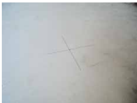
1. Отметить на плите расположение трапа
