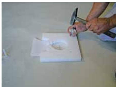
4. Прикрепить с помощью дюбелей нижнюю часть комплекта
