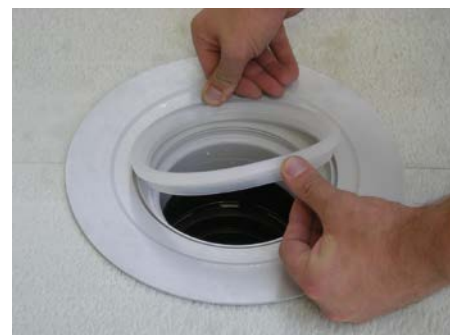
9. Убедиться в правильности установки прозрачного пластикового кольца
