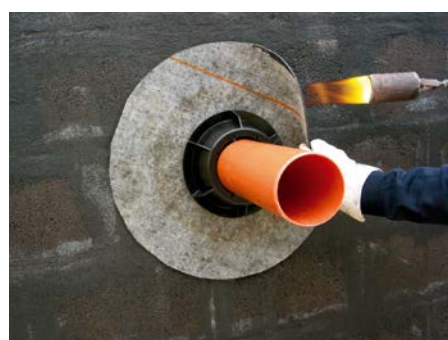
5. Приварить мембрану к битумному покрытию стены
