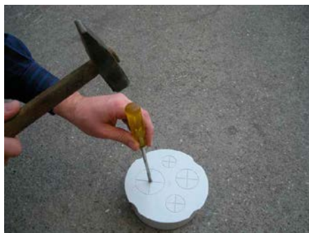
2. В монтажном элементе подготовить отверстия нужного диаметра
