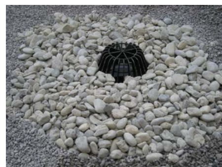
12. Засыпать гравием остальную поверхность кровли
