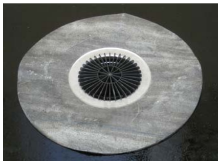
2. Нанести праймер, наклеить 1-й слой гидроизоляции
