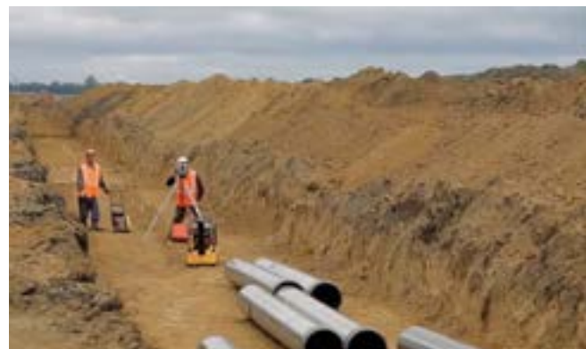
Монтаж напорного коллектора.
