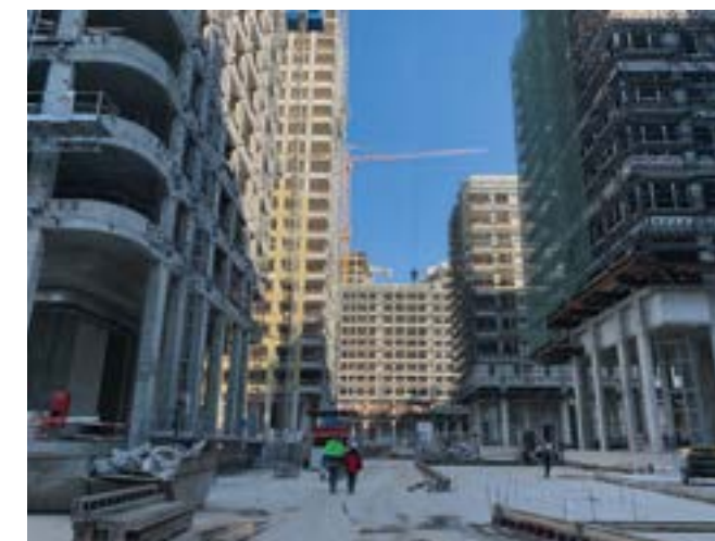
ЖК «ОСТРОВ». Введен в эксплуатацию напорный трубопровод для ливневой канализации.
