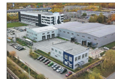
«КВТ» г. Калуга, Академический проезд
