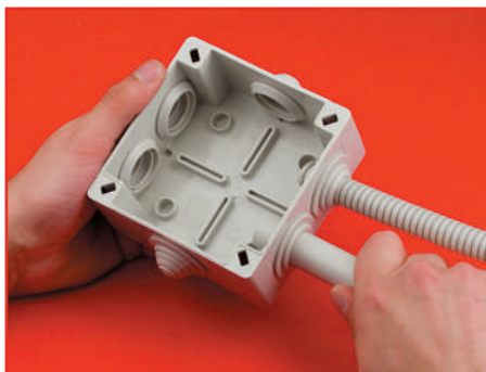
2 этап. Ввести гофрированную и жесткую трубы
