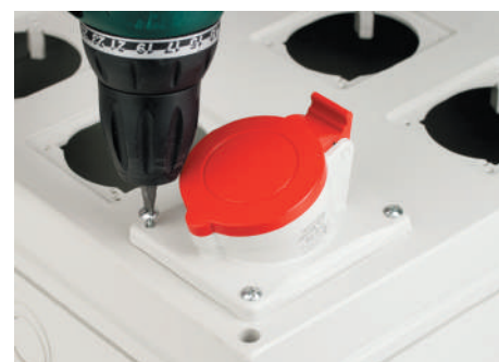
Монтаж розетки на 32 А
