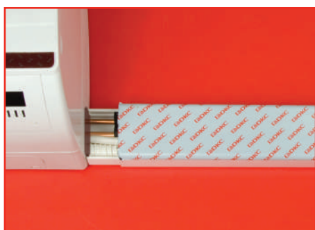
Закройте смонтированную трассу крышкой
