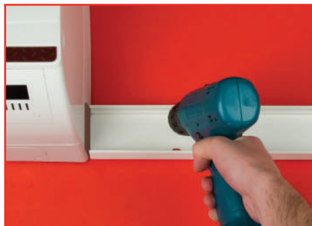
Закрепите основание короба на стене
