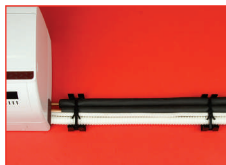
Уложите трассу и закрепите ее при помощи держателей с хомутом
