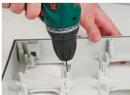
Розетка устанавливается на новые посадочные места. Так как по умолчанию с лицевой стороны данные отверстия заблокированы, то для удобства установки необходимо сделать сквозные отверстия сверлом 3 мм. Отверстия не нужно делать, если устанавливается розетка с фланцем 70×87 мм, например, DIS5706407
